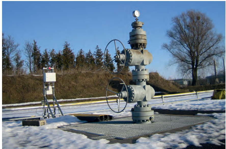
Injektionsbohrung zur CO 2 -Speicherung in Ketzin
