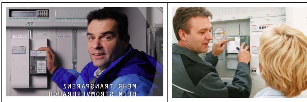
Bild 10 Beispiel für Einbauhöhe eines EDL21-Zählers (Quelle: Bedienungsanleitung EDL21-Zähler, Vattenfall, 2010 und der Schleswig-Holstein Netz AG). Wie man erkennt, schaut der männliche Ableser nach unten, die weibliche Ableserin nach oben. Zur Bedienung der optischen
