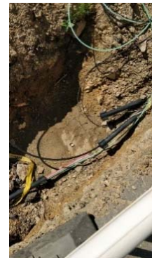
Glasfaserkabel-Verlegung in einem Dorf (Quelle: K. Illigmann)
