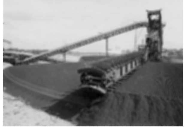
Bild 2. Drehsäulenkratzerförderer zum Ein- und Ausstapeln von Steinkohle
