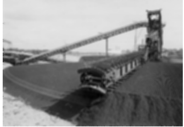
Bild 2. Drehsäulenkratzerförderer zum Ein- und Ausstapeln von Steinkohle
