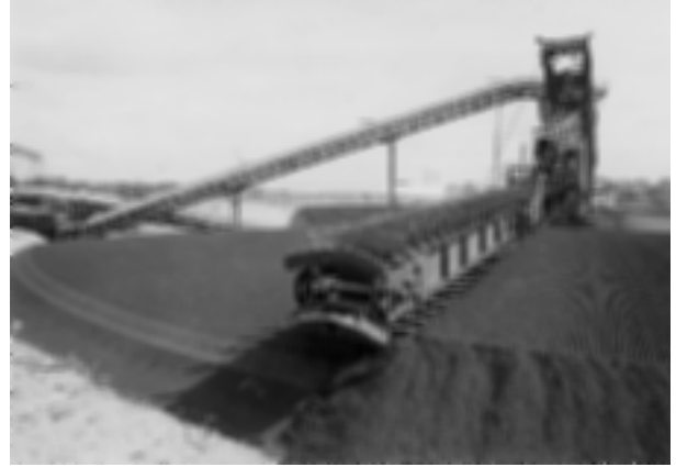
Bild 2. Drehsäulenkratzerförderer zum Ein- und Ausstapeln von Steinkohle
