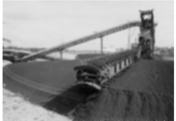
Bild 2. Drehsäulenkratzerförderer zum Ein- und Ausstapeln von Steinkohle
